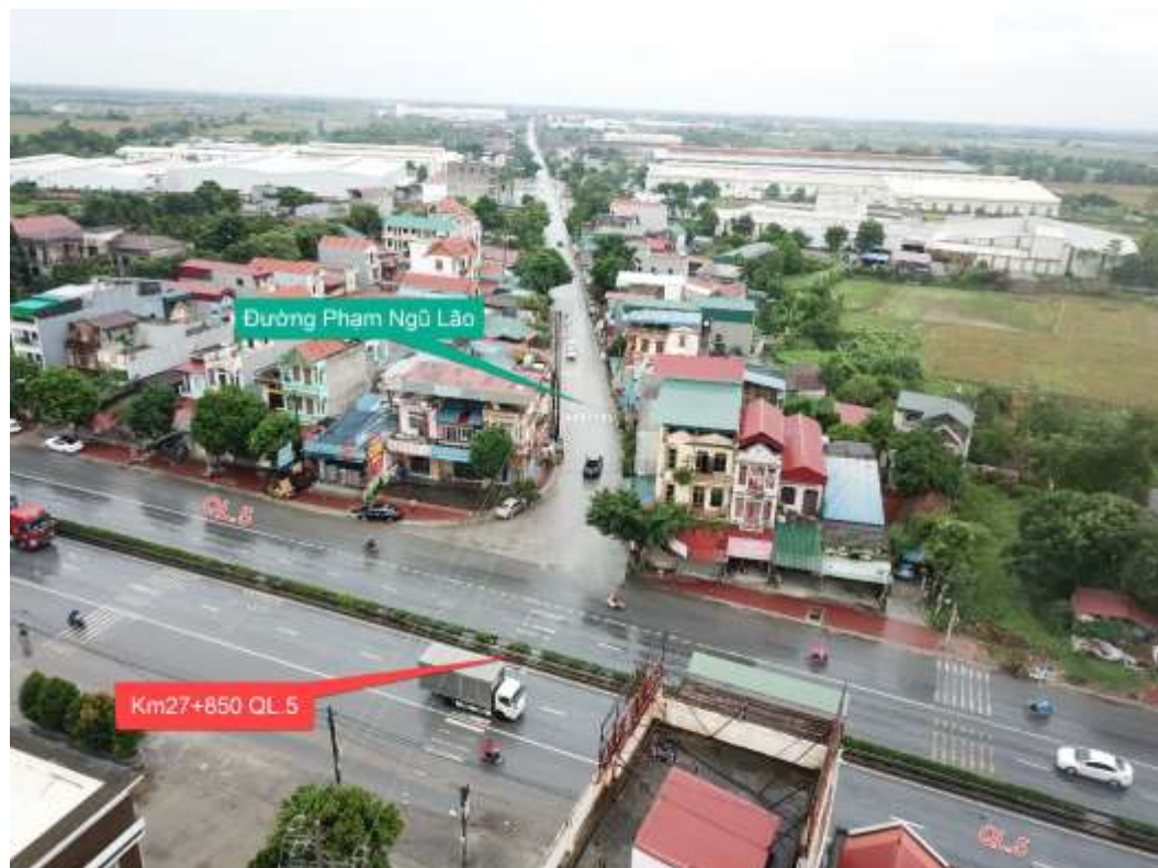
Hình 1. 4. Điểm cuối tuyến nối vào đường Phạm Ngũ Lão
