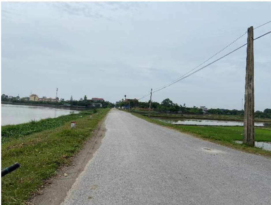
Hình 1. 2. Tuyến đường ĐH.92 phía Tây Nam dự án
