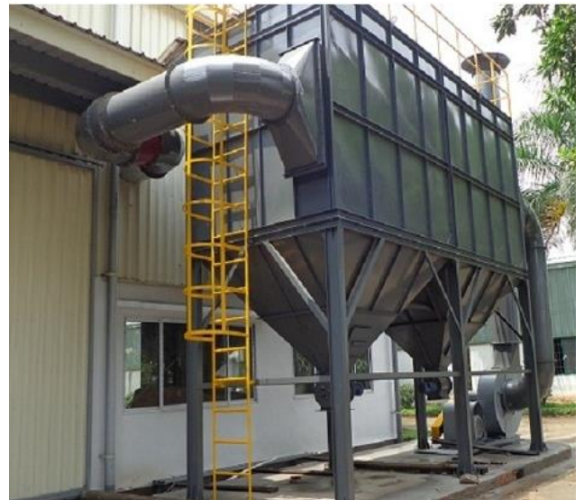
Hệ thống thu hồi bụi túi vải
