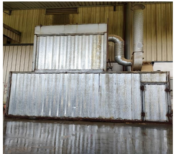
Hệ thống thu hồi bụi túi vải
