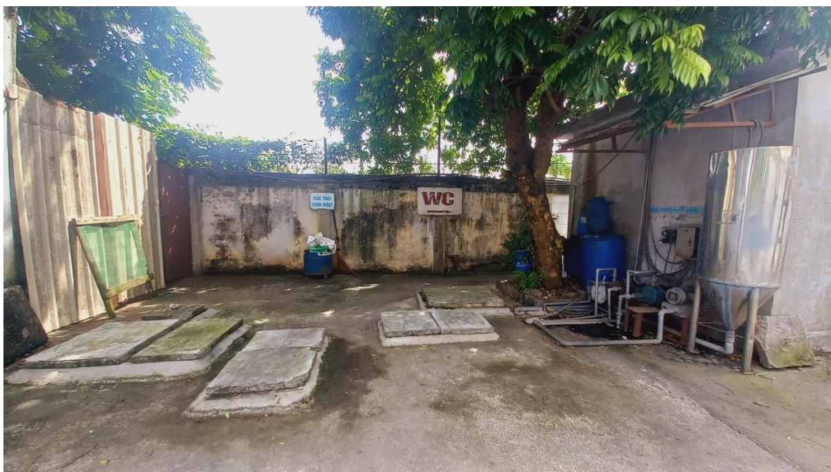
Khu vực hệ thống xử lý nước thải
