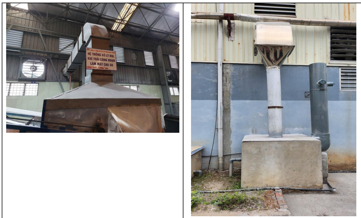
Hình 3. 13: Hình ảnh hệ thống xử lý bụi từ công đoạn xuất dải và làm mát cao su 2.4. Các biện pháp xử lý bụi, khí thải khác
