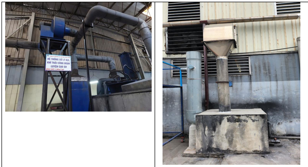
Hình 3. 11: Hình ảnh hệ thống xử lý khí thải từ công đoạn luyện cao su
