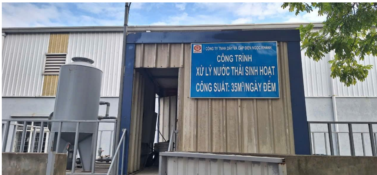
Hình 3. 8: Hình ảnh hệ thống xử lý nước thải tập trung
