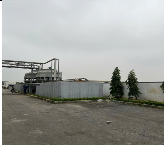
Tháp giải nhiệt nước từ HTXL khí thải
