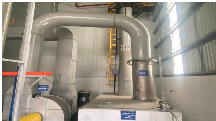
Hình ảnh hệ thống xử lý bụi, khí thải lò dầu tải nhiệt
