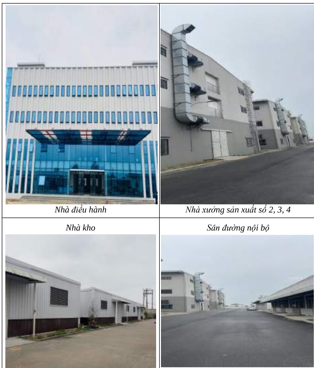
Hình 1. 2 Một số công trình chính đã được xây dựng hoàn thiện của dự án
