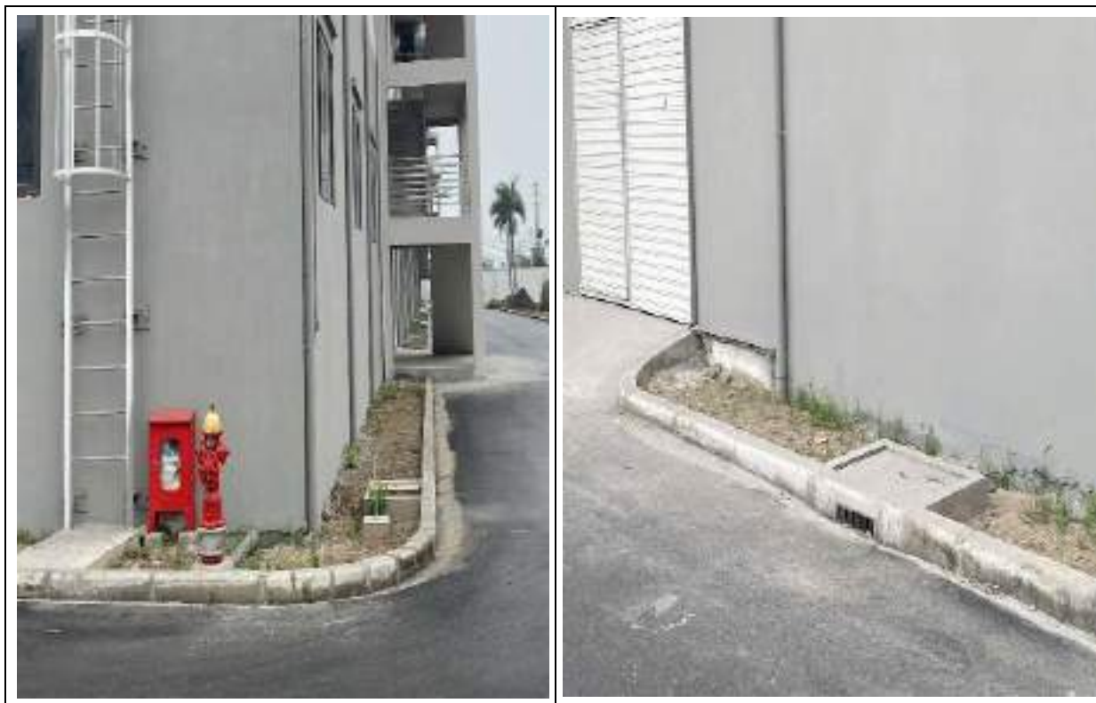
Hình 4. 2 Hệ thống thoát nước mưa và hố ga lắng cặn nước mưa
