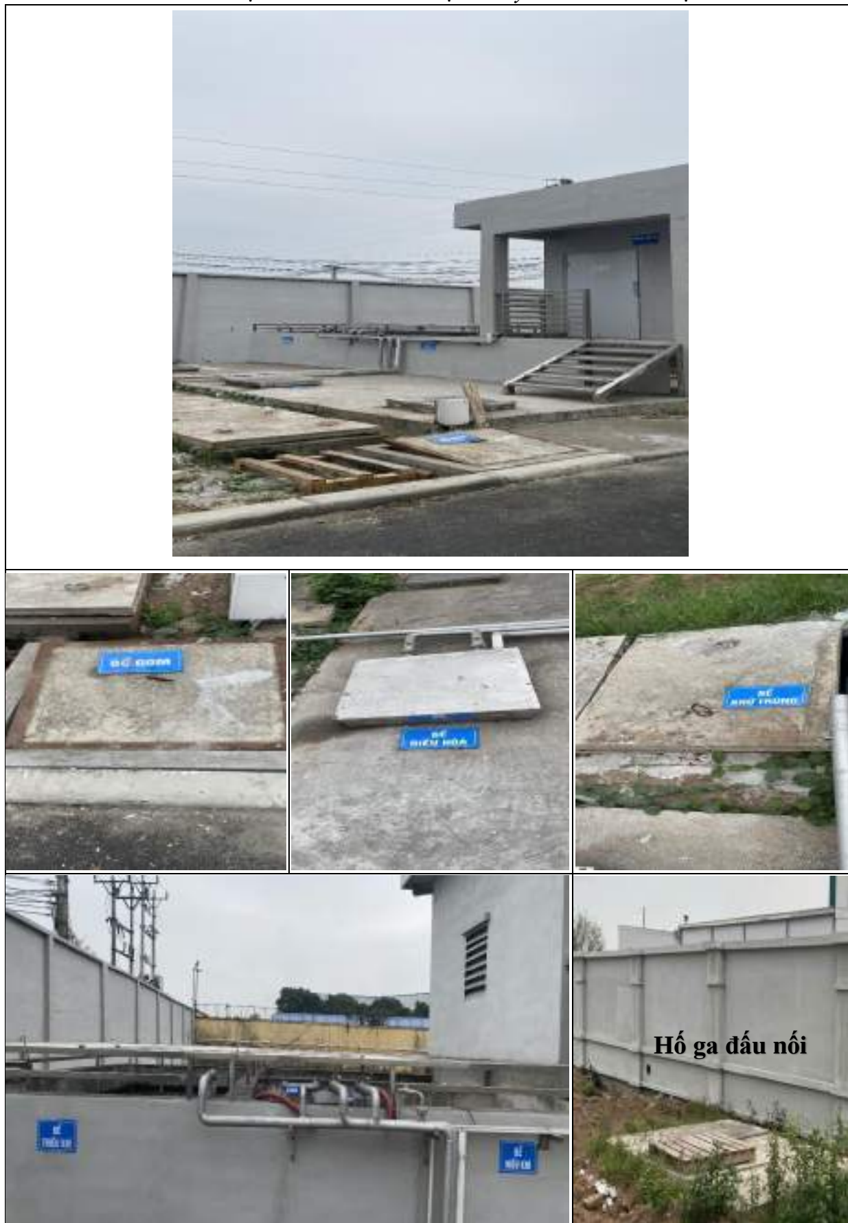
Hình 4. 1 Một số hình ảnh của trạm xử lý nước thải của dự án
