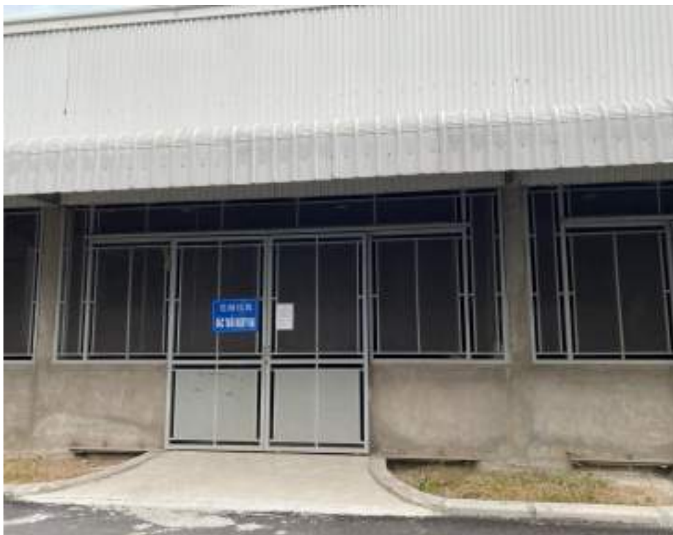
Hình 4. 13 Khu lưu giữ CTNH của dự án
