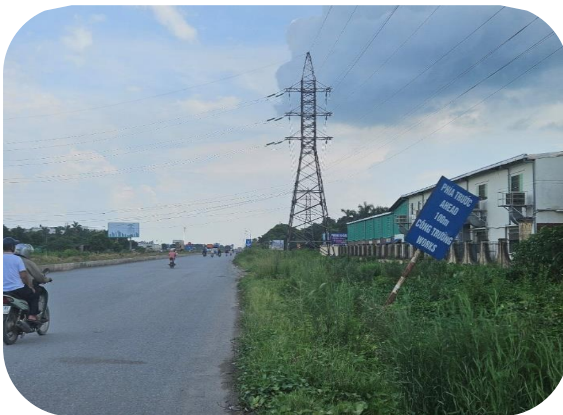
Hình 1.3. Cột điện cao thế 110kv bên phải tuyến đoạn Km0-Km0+756
