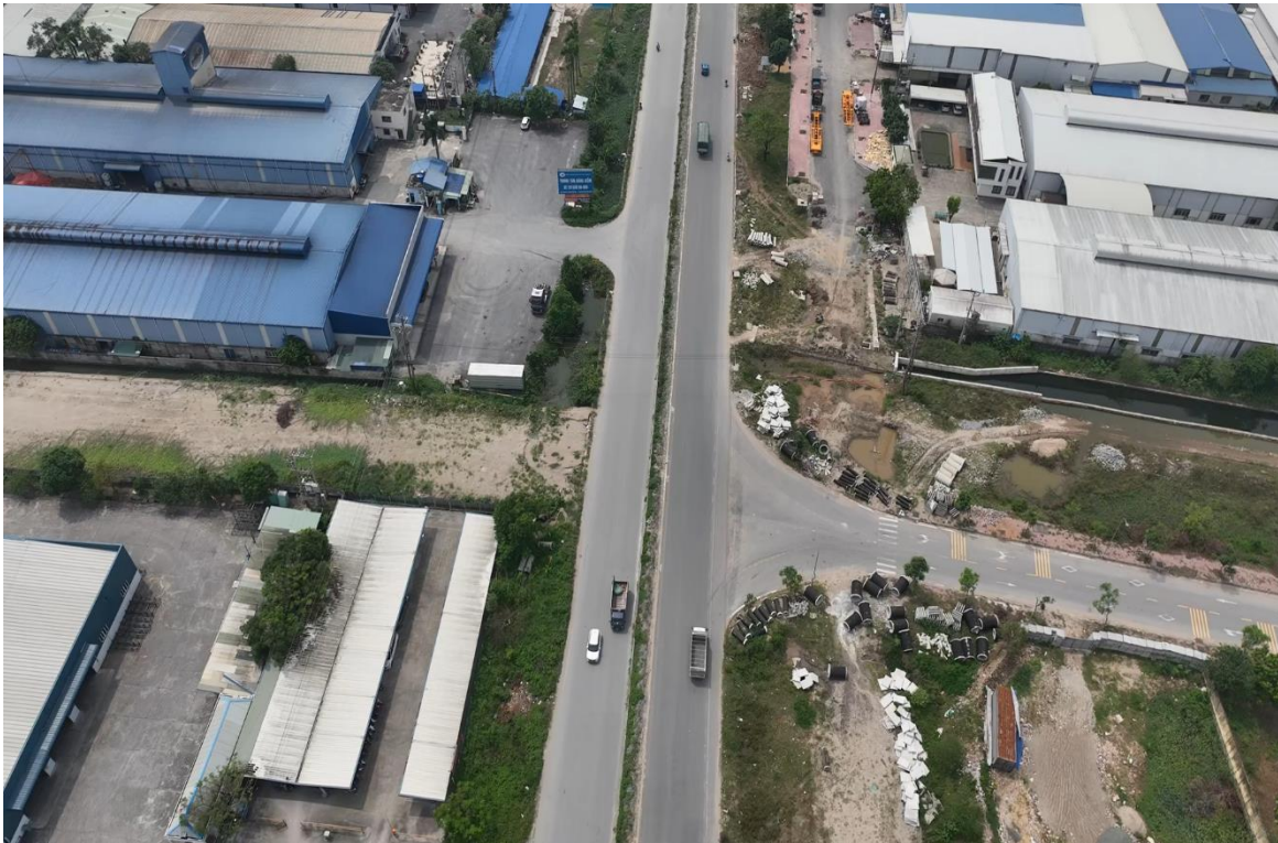
Hình 1.7. Đường gom bên phải tuyến đã đầu tư
