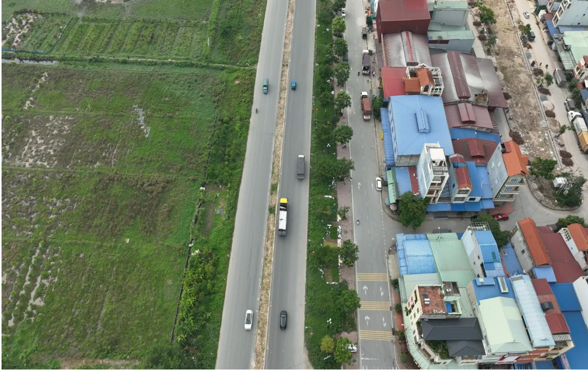
Hình 1.6. Đường gom bên phải tuyến đã đầu tư
