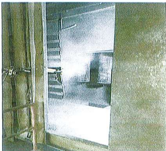
Hình 1. 10. Hình ảnh phun sơn tĩnh điện
