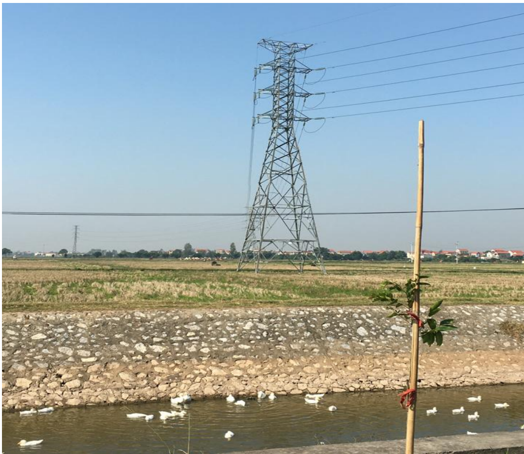
Hình 1. 9. Hiện trạng cấp điện trong khu vực Dự án
