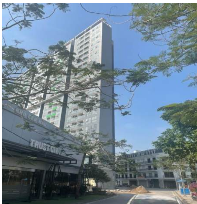
Hình 3. Hình ảnh khu nhà ở cao tầng (khu chung cư 21 tầng) và nhà ở thấp tầng tại dự án
