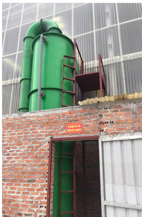
Hình ảnh hệ thống xử lý hơi axit từ quá trình tẩy gi công suất 45.000 m 3 /giờ
