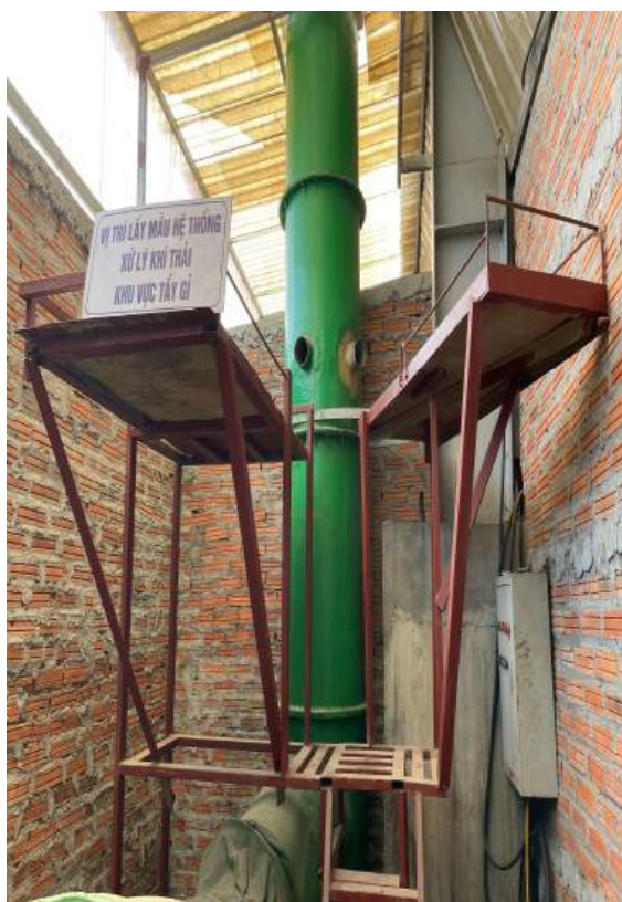
Hình ảnh hệ thống xử lý hơi axit từ quá trình tẩy gi công suất 45.000 m 3 /giờ
