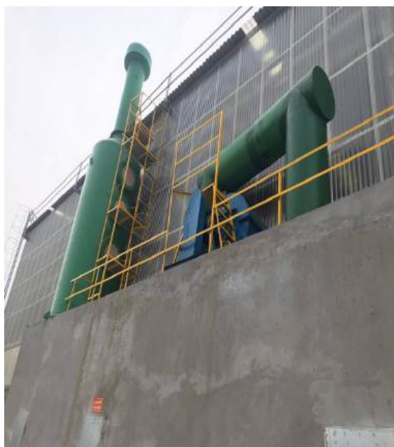
Hình ảnh hệ thống xử lý hơi hóa chất đặt tại khu vực tráng phủ công suất 50.000 m 3 /giờ
