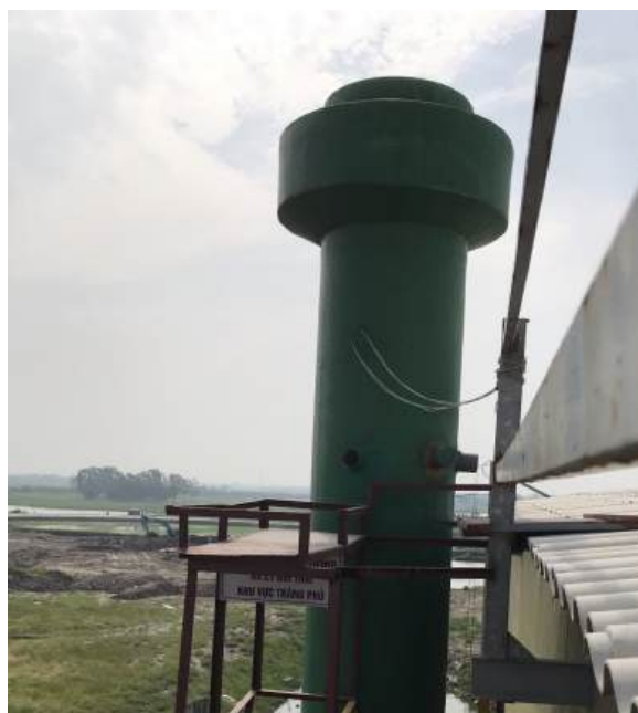
Hình ảnh hệ thống xử lý hơi hóa chất đặt tại khu vực tráng phủ công suất 50.000 m 3 /giờ
