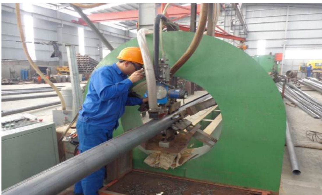
Hình 7. Hình ảnh công đoạn hàn
