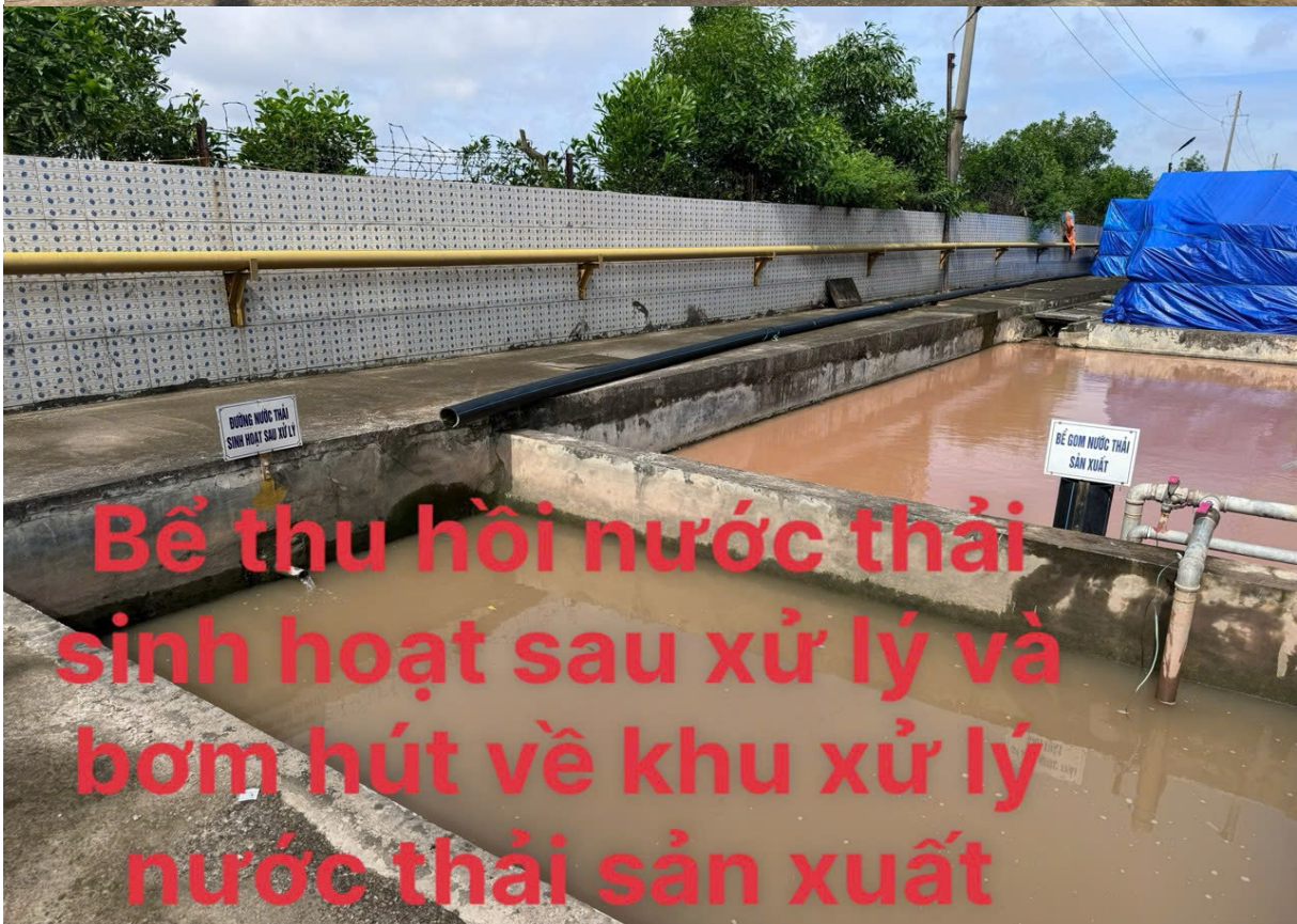
Hình 1. 2 Trạm xử lý NTSH và bể thu gom NTSH và NTSX về khu xử lý NTSX
