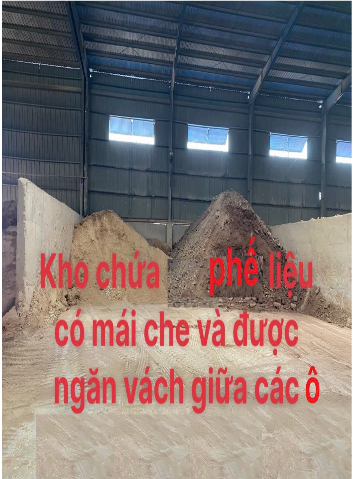
Hình 1. 7 Kho chứa phế liệu hiện có của Nhà máy
