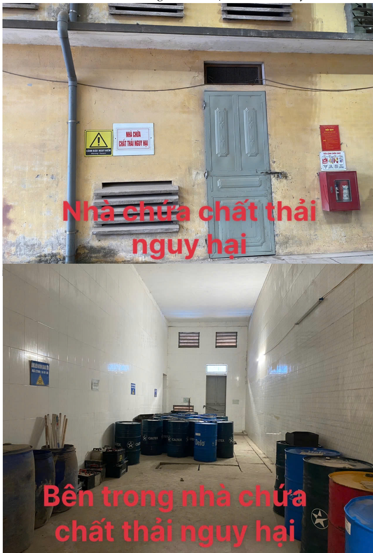
Hình 1. 8 Khu lưu giữ CTNH hiện có của Nhà máy
