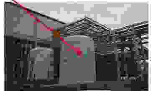
Tank chứa acid thải
