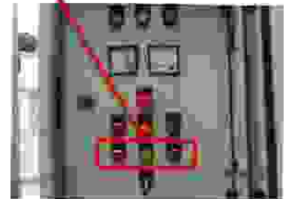
Rơ le thời gian của van xoay Timer of rotary valve
