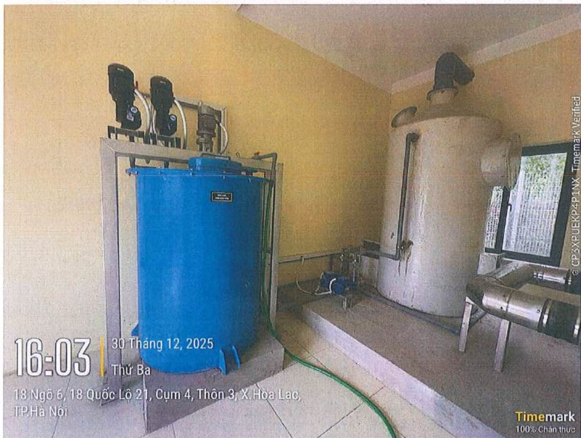
Hình 4. 6. Hình ảnh minh họa tháp hấp thụ bằng dung dịch NaOH
