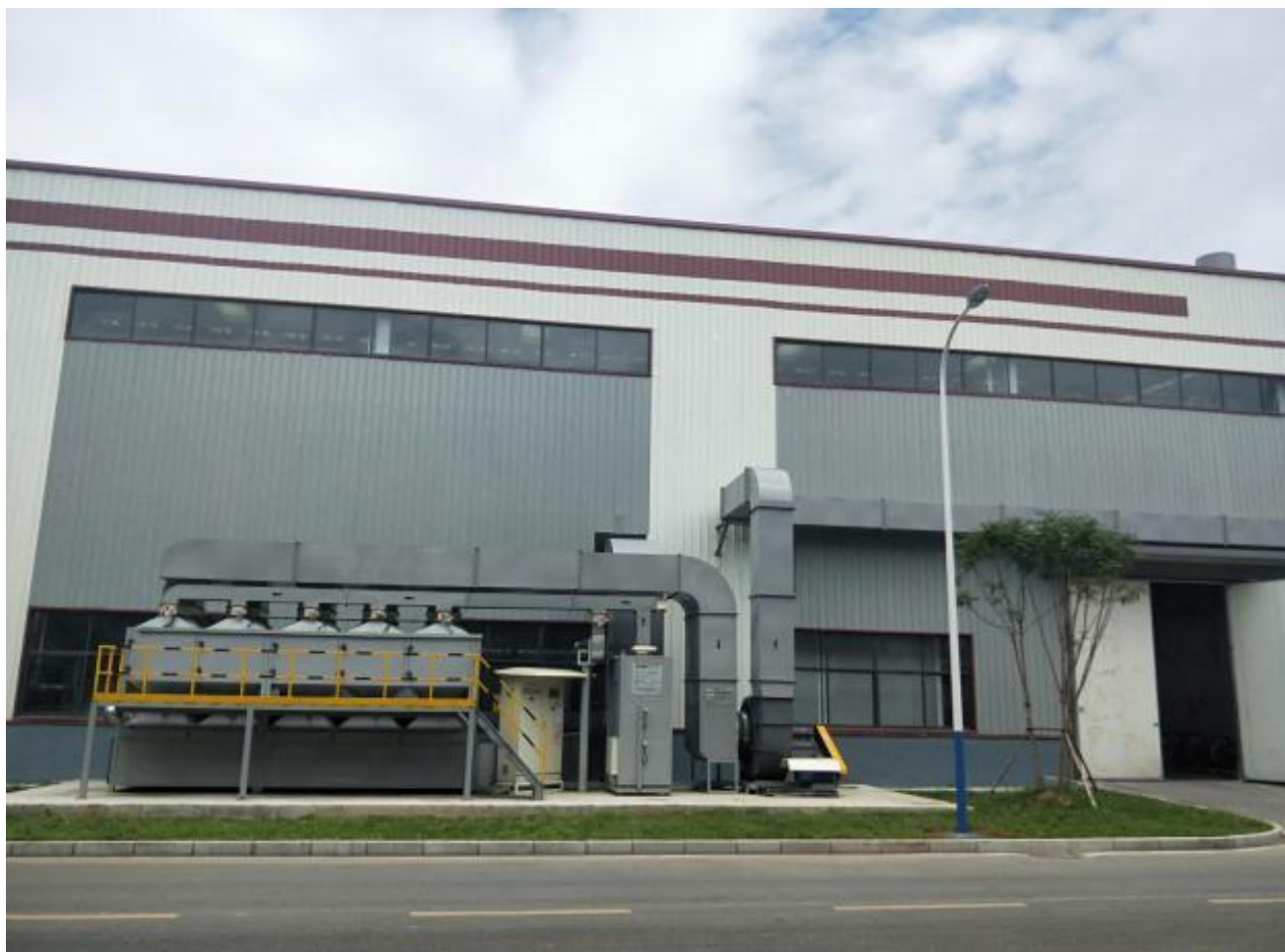
Hình 4.12. Hệ thống xử lý khí thải RCO minh họa
