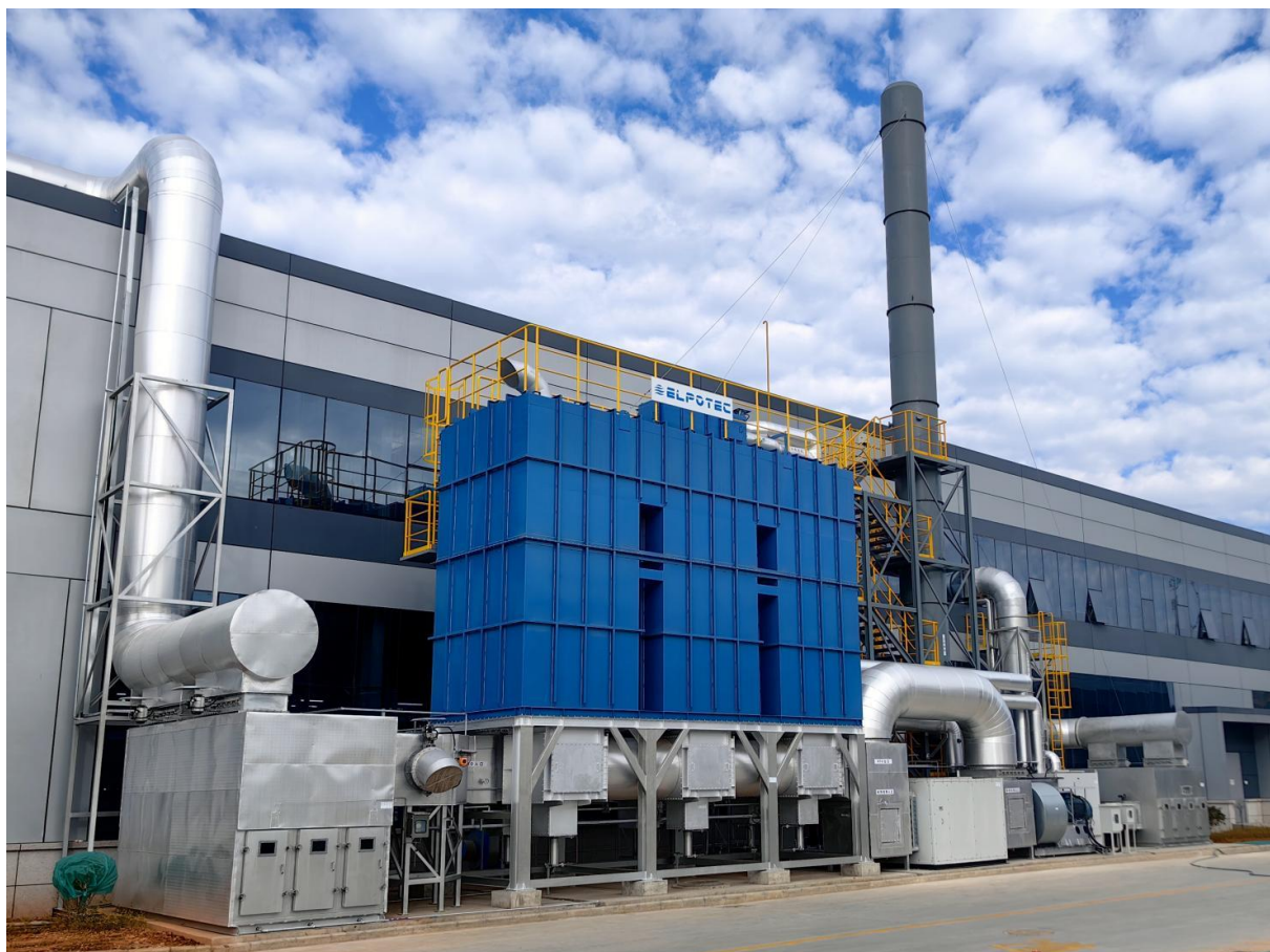
Hình 4.10. Hệ thống xử lý khí thải RTO minh họa
