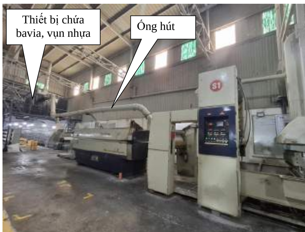
Hình 3. 16. Hình ảnh hệ thống thu hồi bavias, vụn nhựa thừa * Biện pháp giảm thiểu khí thải do lò gia nhiệt chân không xử lý lưới
