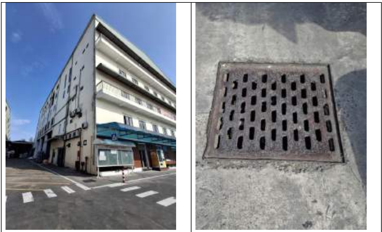
Hình 3. 1. Hình ảnh thu gom nước mưa của dự án
