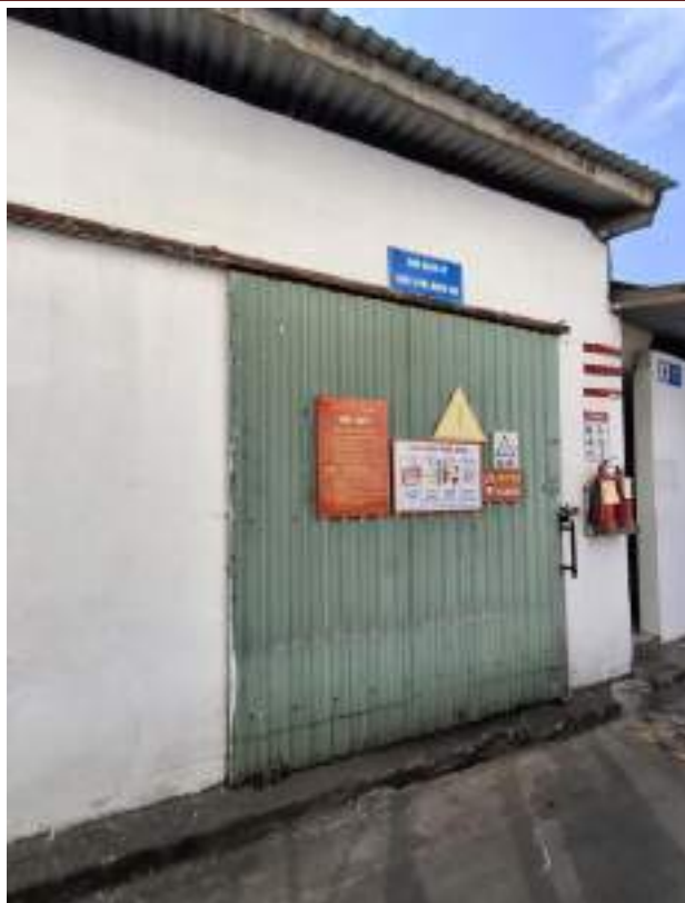
Hình 3. 20. Hình ảnh khu lưu giữ chất thải nguy hại của nhà máy 5. Công trình, biện pháp giảm thiểu tiếng ồn, độ rung
