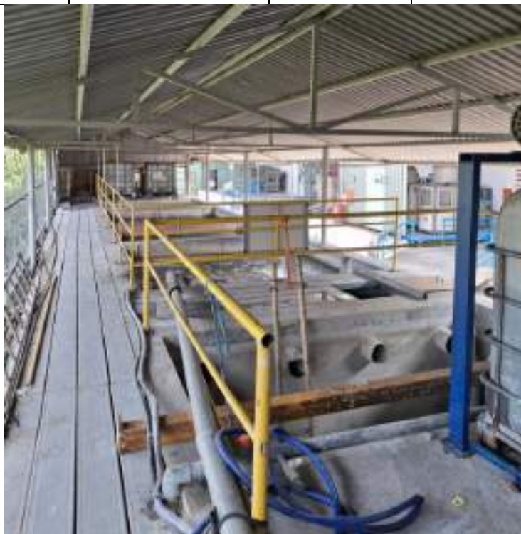
Hình 3. 9. Hình ảnh hệ thống xử lý nước thải sản xuất của nhà máy * Hồ điều hoà:
