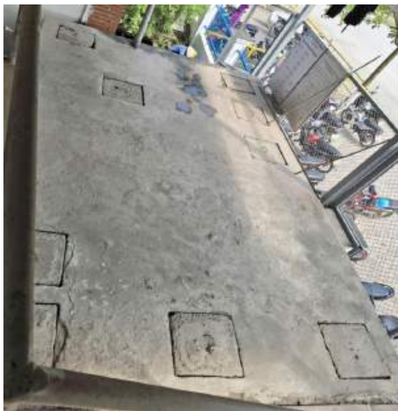
Hình 3. 7. Hình ảnh hệ thống xử lý nước thải sinh hoạt của nhà máy Hệ thống xử lý nước thải sản xuất:
