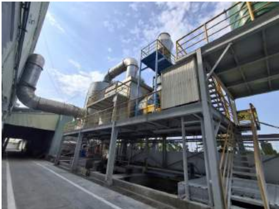
Hình 3. 14. Hình ảnh hệ thống xử lý khí thải của nhà máy * Hệ thống thu hồi bavias:
