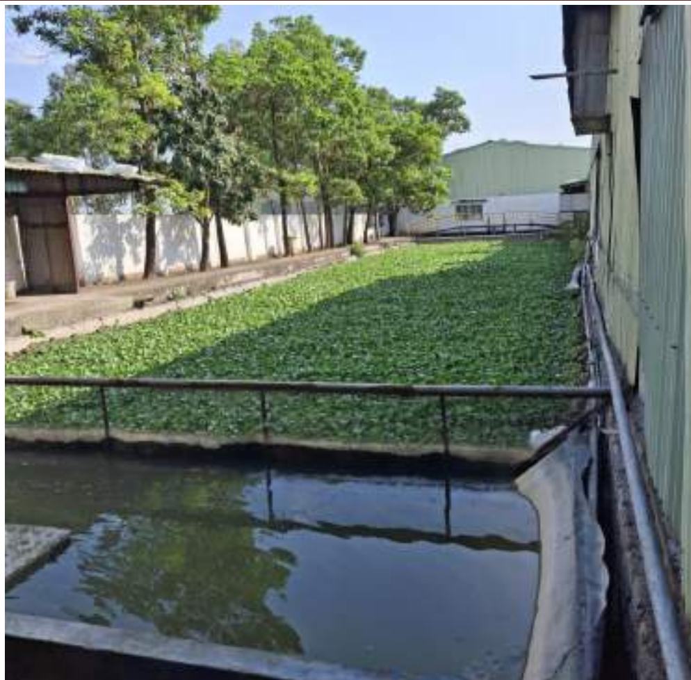
Hình 3. 10. Hình ảnh hồ chứa nước được lót màng chống thấm + Hệ thống thu gom nước làm mát từ công đoạn đùn ép và kéo sợi để sử dụng cho sản xuất:
