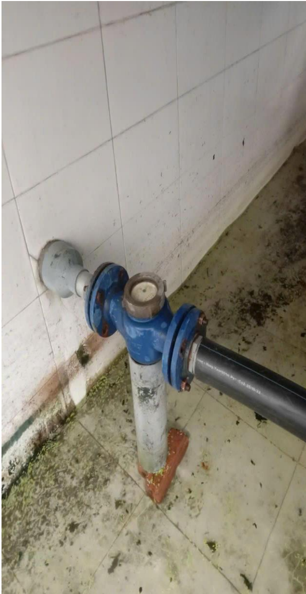
Hình 3. 2 Đồng hồ đo lưu lượng nước thải sau xử lý và điểm xả nước thải sau xử lý của Nhà máy ra kênh Hoài của khu vực
