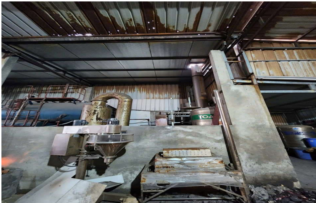
Hình ảnh HTXL bụi, khí thải lò hơi
