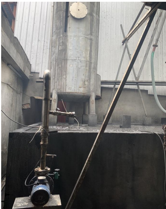
Hình 3.6. Hình ảnh hệ thống xử lý khí thải lò hơi
