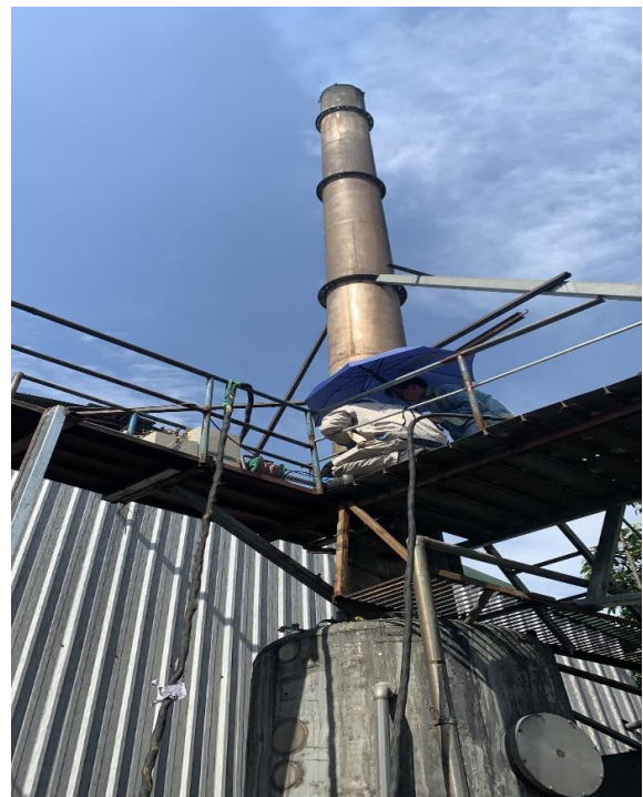
Hình 3.6. Hình ảnh hệ thống xử lý khí thải lò hơi
