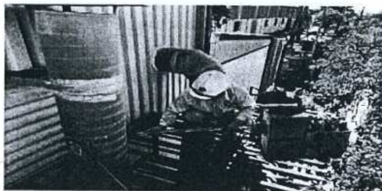
Hình 3.9. Ống phóng không sau hệ thống thu hồi bụi
