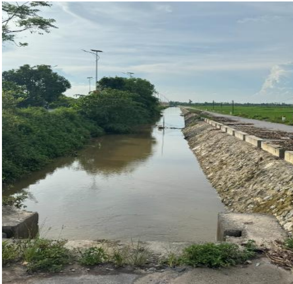
Kênh tiêu T1-22 cạnh khu đất dự án
