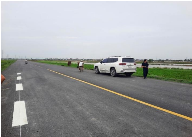
Hiện trạng tuyến đường tránh QL.38 cắt ngang qua khu đất dự án
