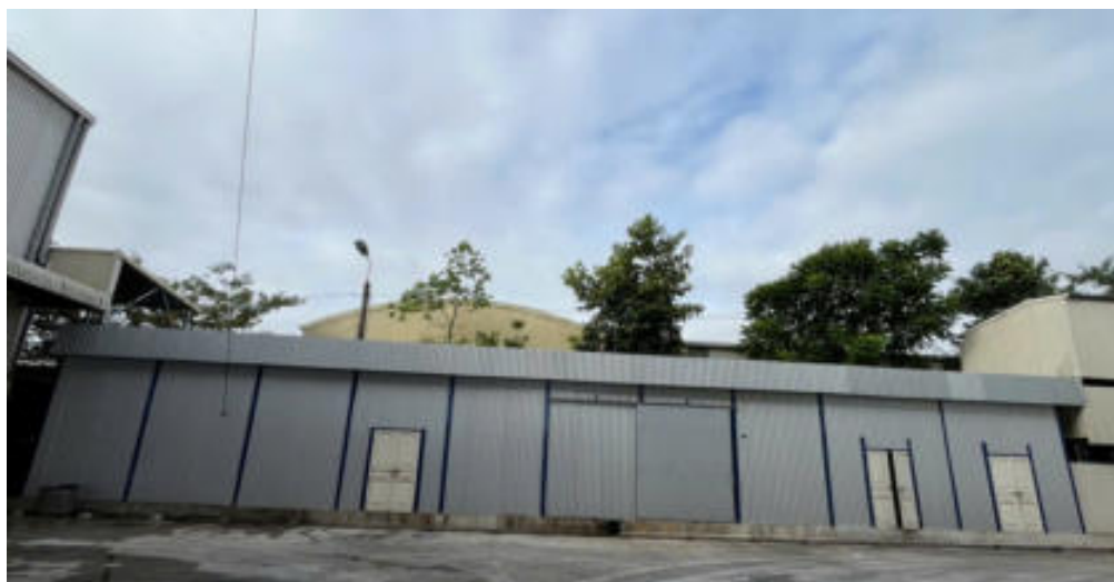
Hình 3. 3 Khu nhà lắp đặt máy ép bột khung bản
