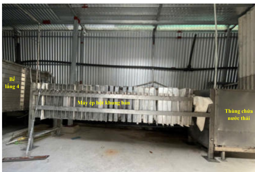
Hình 3. 4 Máy ép bột khung bản
