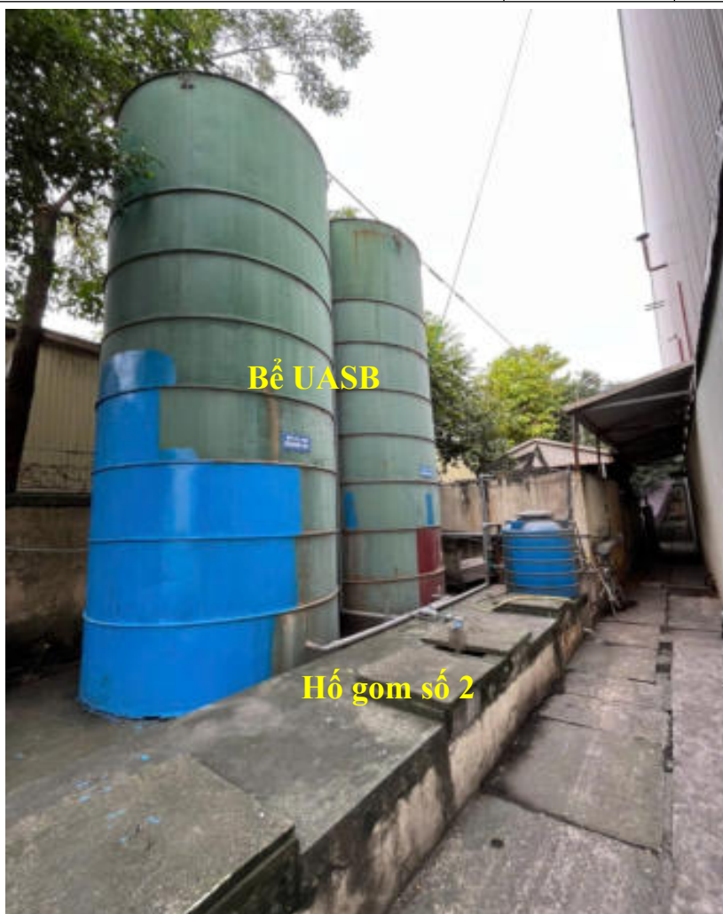
Hình 3. 6 Khu vực trạm xử lý NTSX công suất 100 m 3 /ngày đêm
