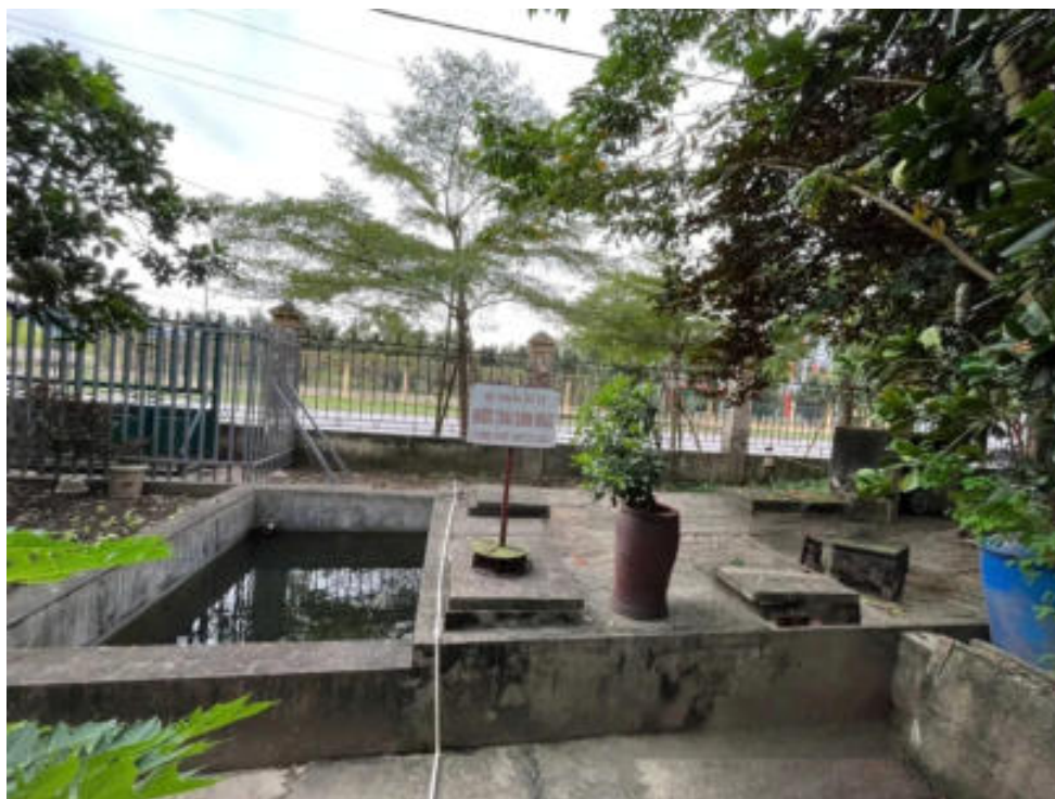
Hình 3. 5 Khu vực trạm xử lý NTSH công suất 10 \text{ m}^3/\text{ngày đêm}
