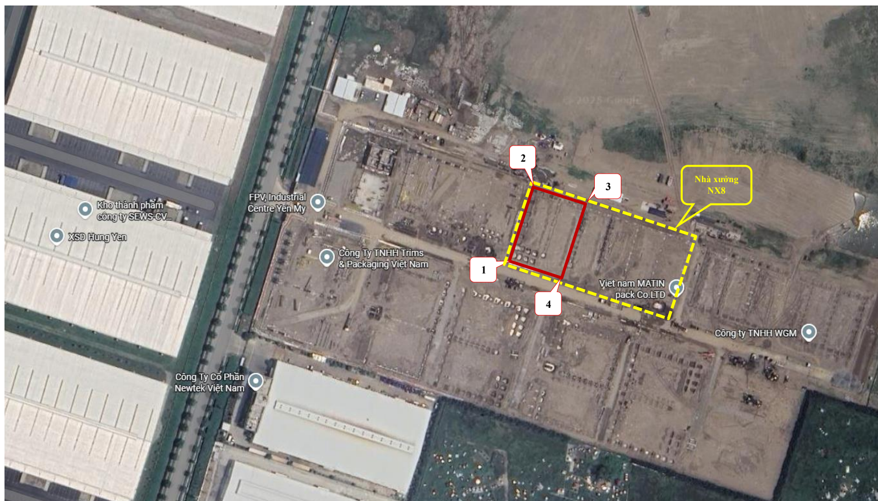
Hình 1.1. Vị trí nhà xưởng xây sẵn NX8-1 và 8-2 trên bản đồ vệ tinh
